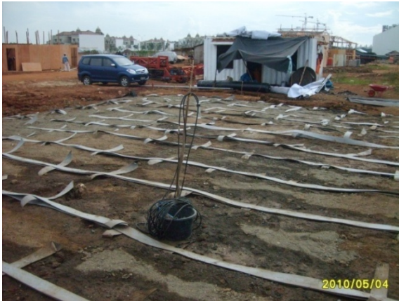
Gambar 9. Pemasangan jaringan GVS.
