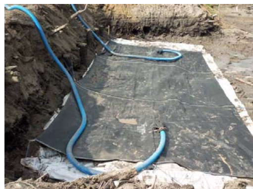
Gambar 17. Penggelaran material Geotube.
