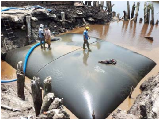
Gambar 18. Proses pemompaan pasir ke dalam Geotube.
