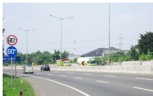
Gambar 14 Sistem penempatan signage sisi di sisi kiri jalan raya, di jalan raya tol Bintaro
