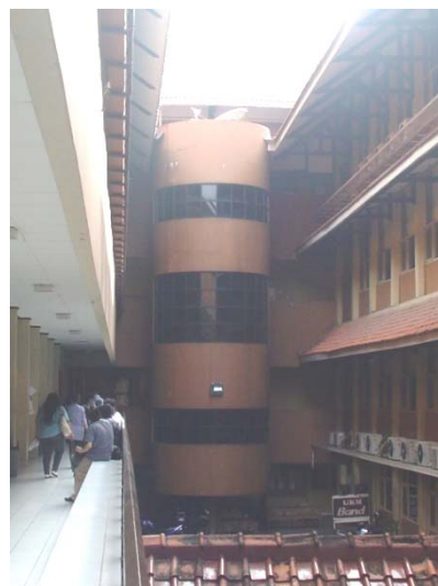
Gambar 16 Tangga Utama di Belakang Gedung
